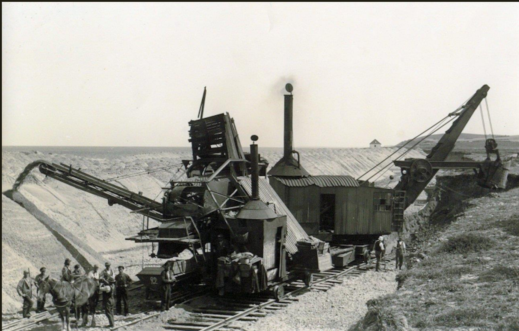
Der graves i nærheden af Strandvejen. Grave- og sorteringsmaskinerne kører her på skinner i udgravningen. Gravemaskinen bagest graver i skråningen til højre, og afleverer indholdet til sorteringsmaskinen. Efter grovsortering fyldes tipvognene og resten glider på et transportbånd ud til siden og danner 'topperne' eller 'sanddupperne' – som de bliver kaldt. (1930'erne.)
