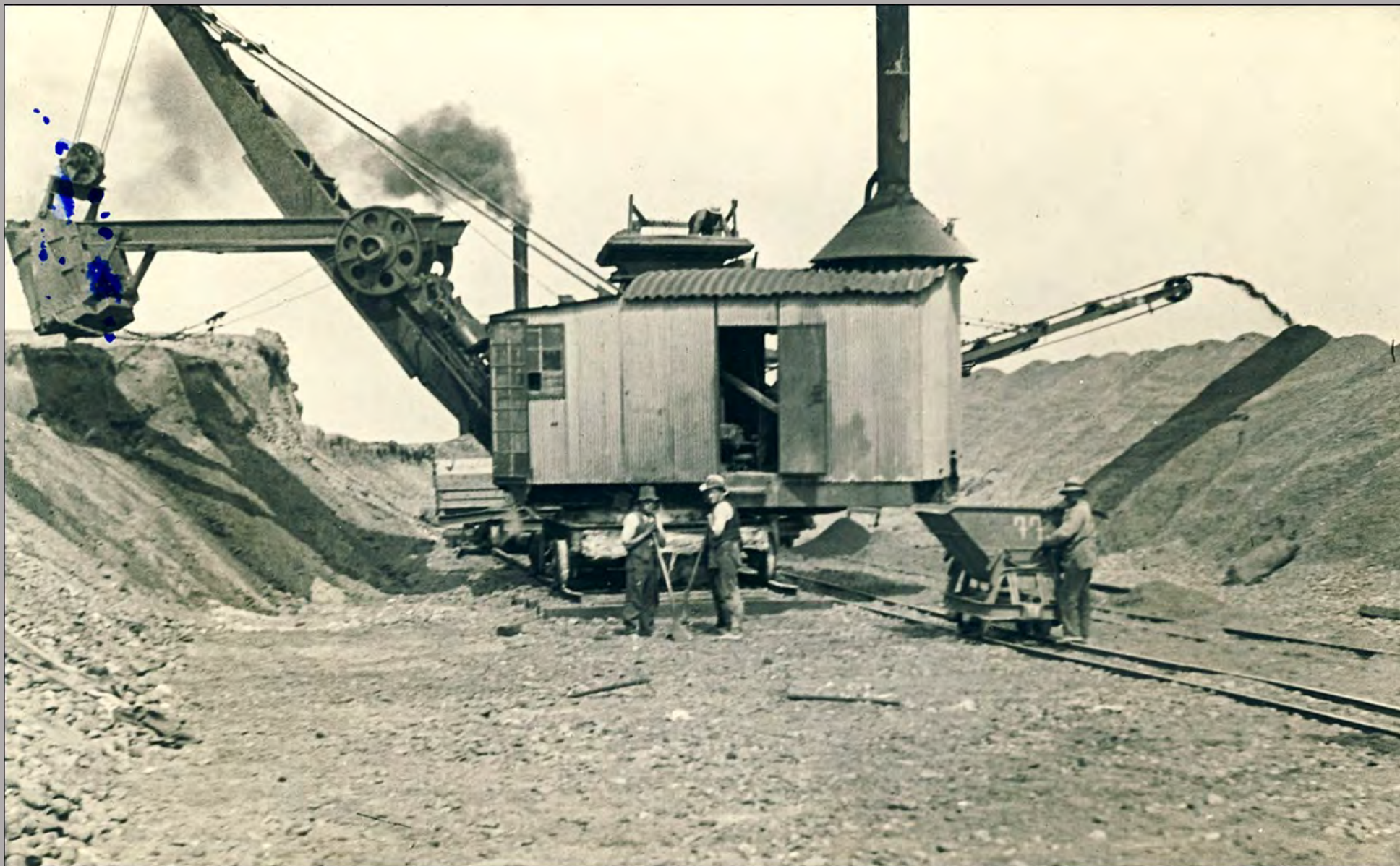
Maskinen graver og sorterer – læsser sten i tipvogn - det fine grus er affald til topper
